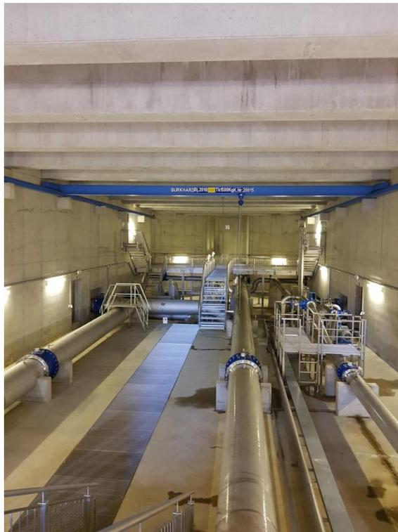
Abb. 4: Schieberkammer – Rohrnetz in dem Wasserbehälter Wienerberg
